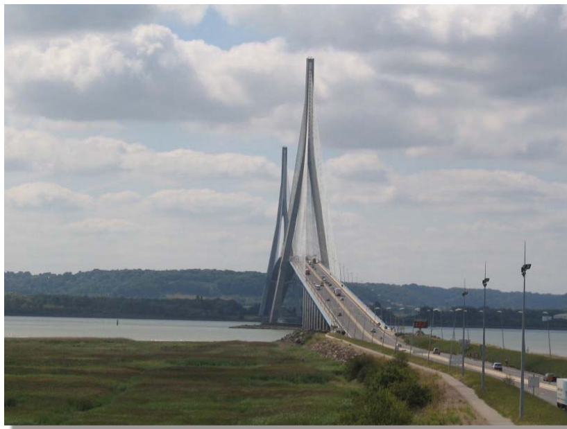
Pont de Normandie
